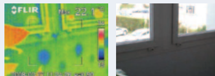
Figure 7 : Analyse thermographique des parois
