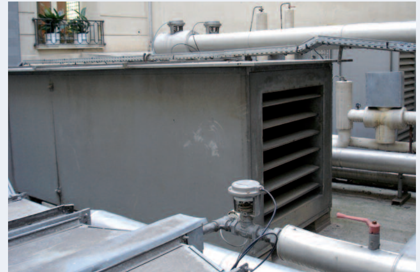
Figure 28 : Vue des CTA n° 28 et 29 : soufflage cuisines Debussy – Ravel et cuisine gastronomique
