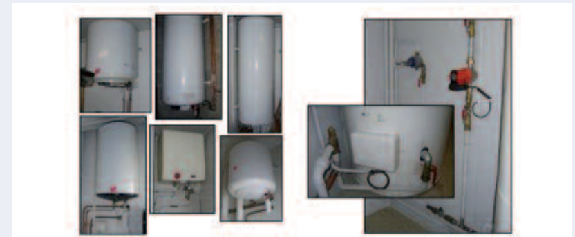
Figure 34 : Les 6 ballons petites et moyennes capacités - le ballon 500 l et son bouclage
