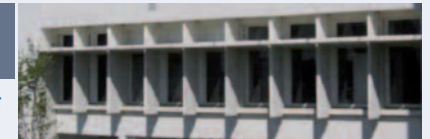
Vue des masques en béton de la façade sud
